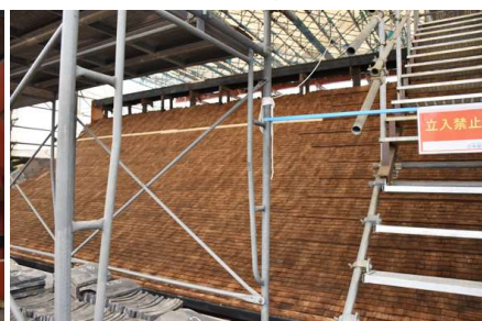
瓦の下にあった土を撤去して屋根を軽量化 なる2027年秋の完成・開門を目指している。 東京大学は昨年10月に赤門修繕のため寄付金を集める「ひらけ！赤門プロジェクト」を 開始しており、現在も寄付を募っている。
